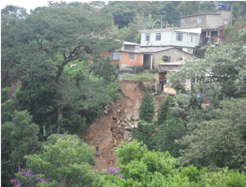
Casas interditadas após deslizamento
