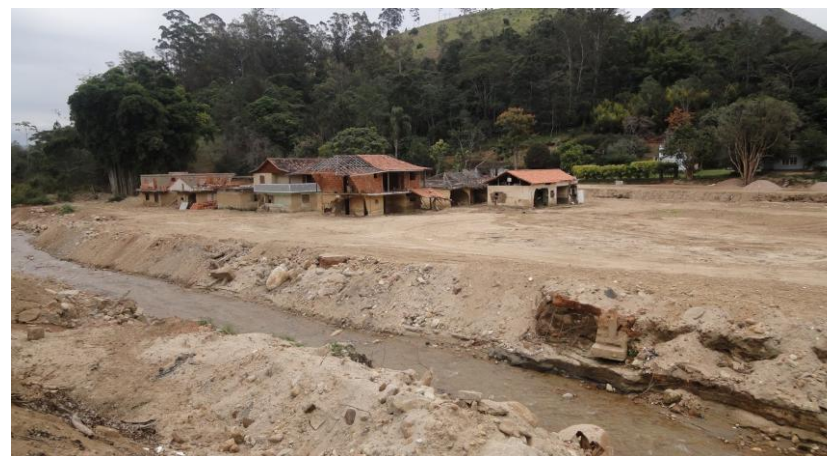
Vale do Cuiabá – Petrópolis / RJ, após as chuvas de janeiro de 2011.
