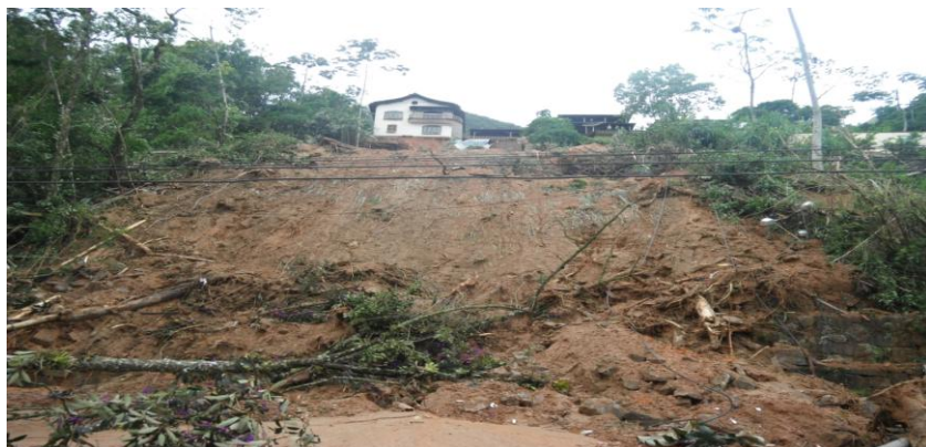
Deslizamento – março de 2013
