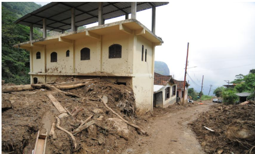
Deslizamento de terra ocorrido no desastre de março de 2013 Neste ano 34 pessoas perderam suas vidas
