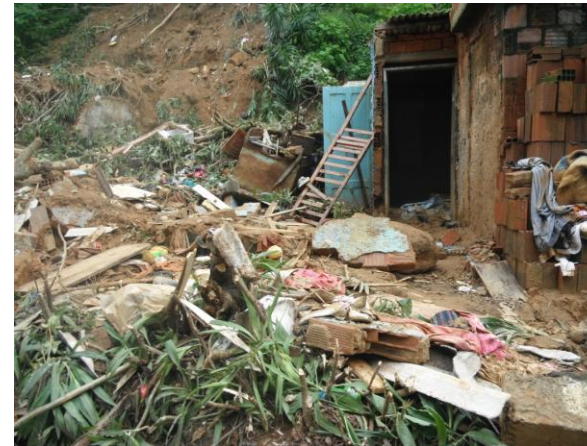
Casas destruídas após deslizamento
