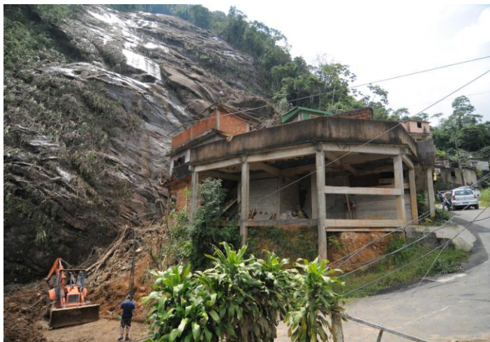
Casas atingidas por deslizamento de terra comunidade do Morin
